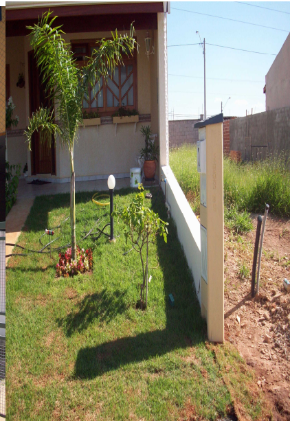
Pedestal lateral entrada BT subterrânea
