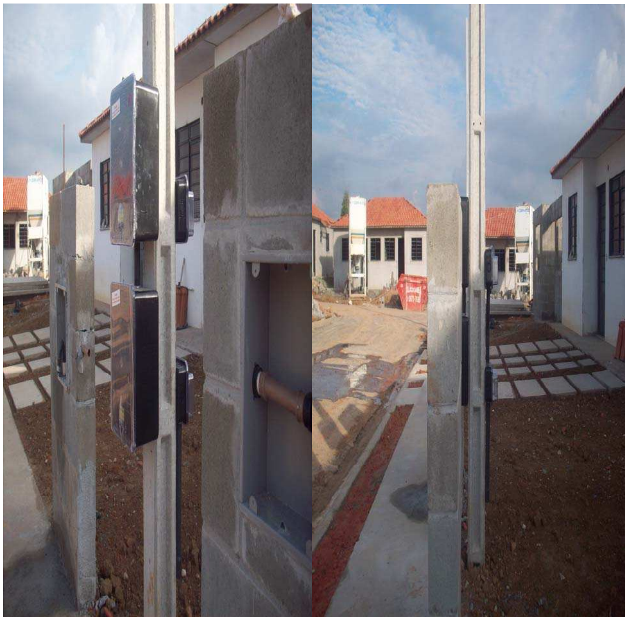
Padrão de entrada compacto frontal duplo com caixas de policarbonato
