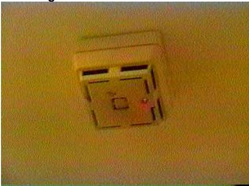
2) Acionador manual, que se constitui em parte do sistema destinada ao acionamento do sistema de detecção;
